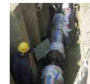
NS形接合工事
