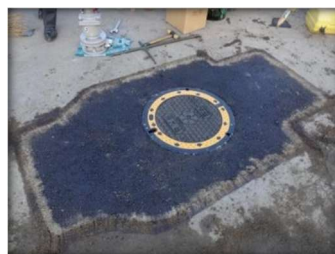
埋設箇所外観
