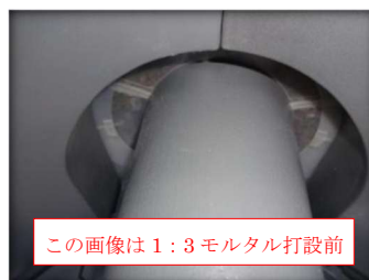
ピット内部（パッキン部）
